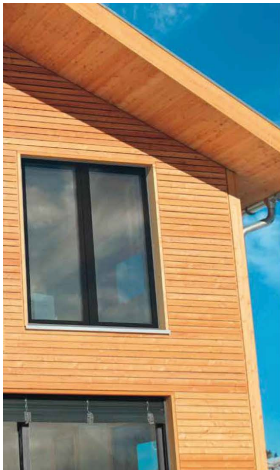
Holz/Aluminum Fenster SelectionPlus (Bautiefe 105 mm)
